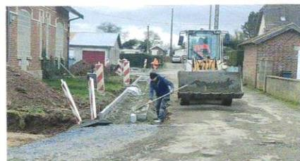
A ce stade, le gros œuvre a été accompli et la chaussée est entièrement restructurée. La SAUR doit maintenant intervenir pour remplacer la conduite d'eau obsolète, enfouie dans ce secteur. A l'approche de l'été, les enrobés seront mis en œuvre, en même temps que seront rénovées les bandes de roulement des rues de la Paix, de la République et de Paris.
